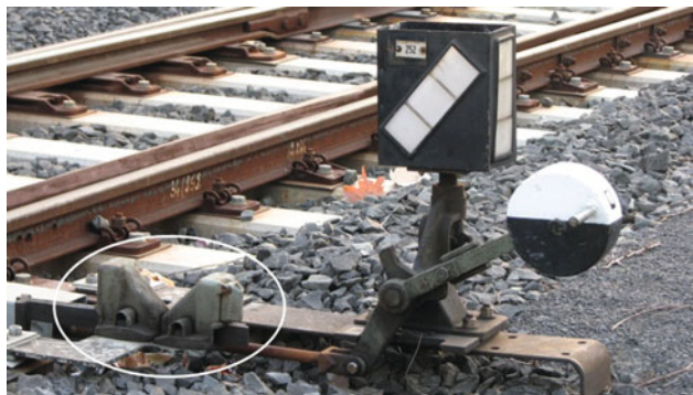
Abb. 4.43 Riegelhandschlösser an einer mechanisch ortsbedienten Weiche (je eines pro Stellung)
