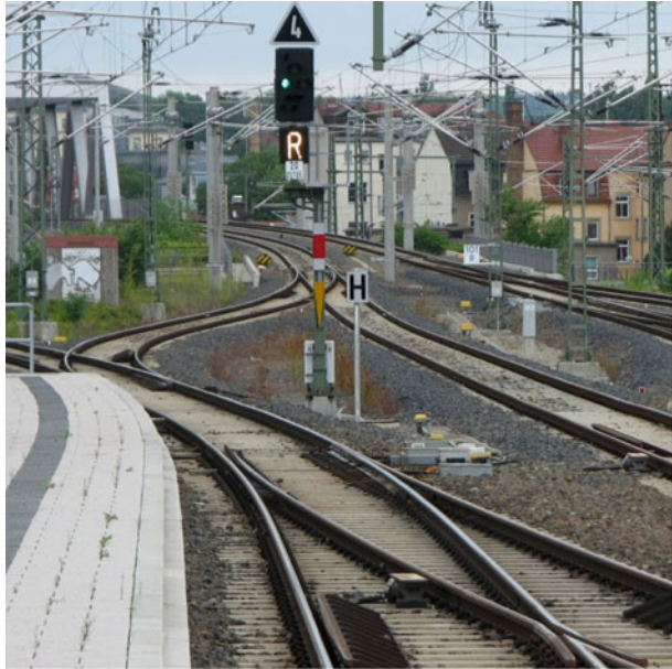
Abb. 5.17 Mittelweiche vor einem Ausfahrtsignal
