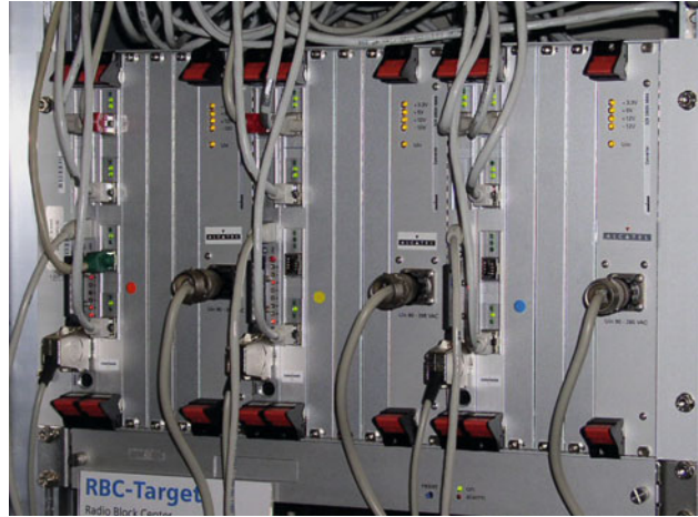
Abb. 7.12 2v3-Rechnersystem eines RBC
