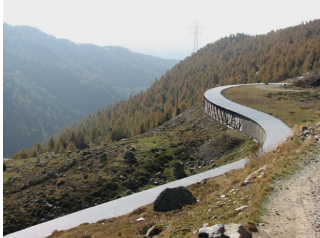
Abb. 2.4 Einhausung einer Eisenbahnstrecke im Hochgebirge als Schutz vor Schnee und Lawinen
