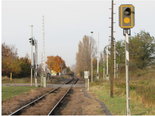
Abb. 8.6 Überwachungssignal vor dem Bahnübergang einer Anschlussbahn
