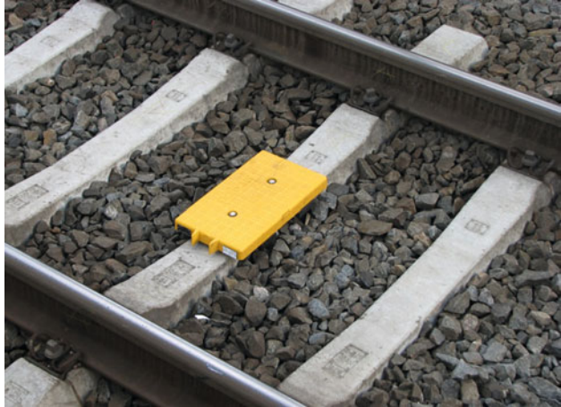
Abb. 7.4 Im Gleis montierte Eurobalise
