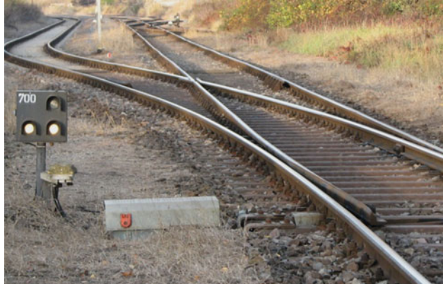
Abb. 4.37 Elektrisch ortsbediente Weiche mit Weichenlagemelder
