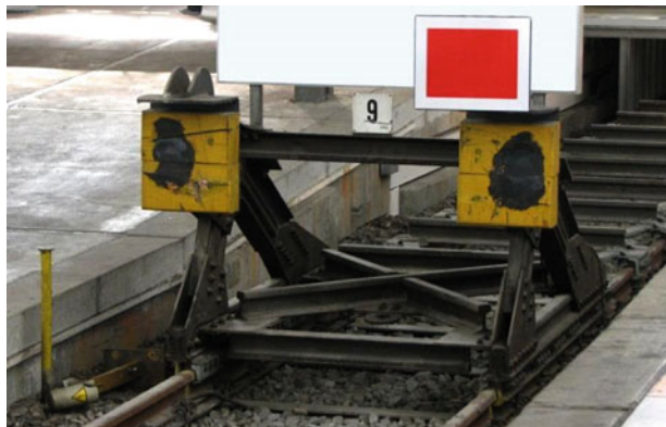
Abb. 5.7 Prellbock mit Signal, an dem eine Fahrstraße endet
