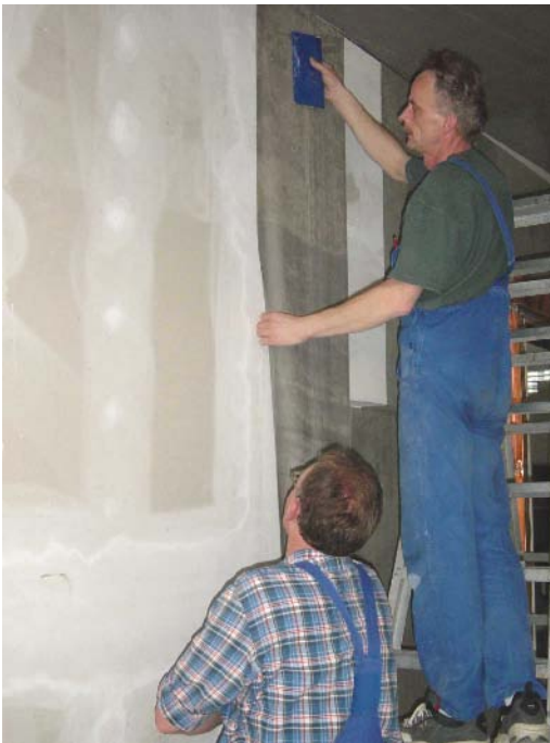
Bild 4.47 Überlappende Verarbeitung von Schirmungsmaterial auf Nylonbasis.
