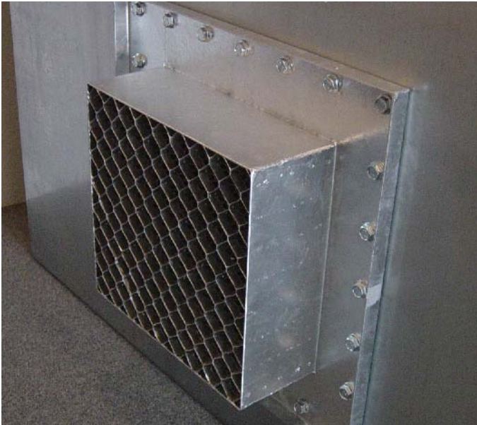
Bild 4.63 Wabenkamin in einer Schirmkabine.
